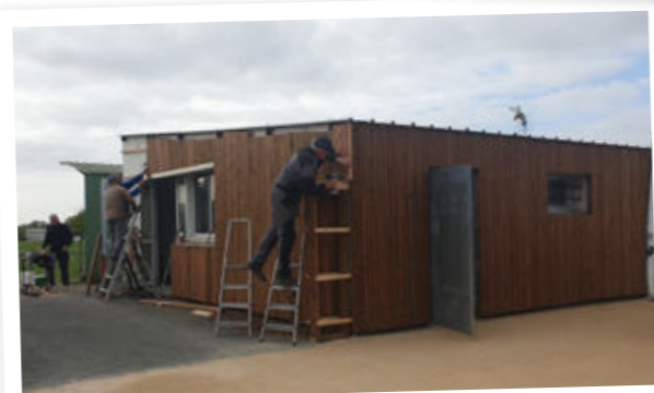
Habillage bois des locaux du foot
